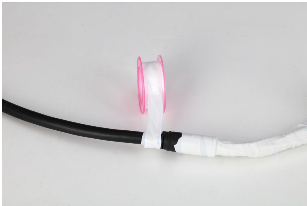
Obrázek 1-4 Vytvoření vodotěsné izolace (1)
